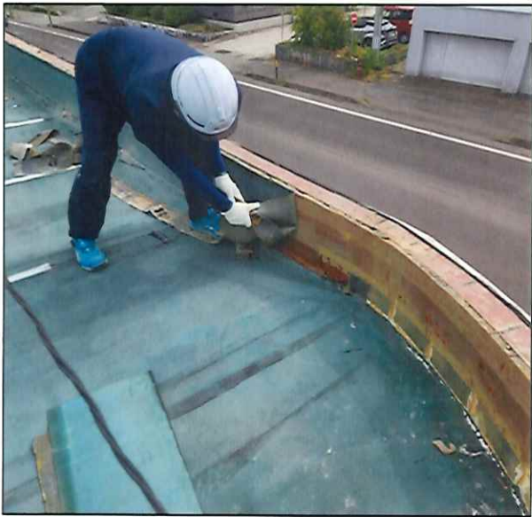
羽後のうさん 屋根防水改修工事(キャンピー屋根)
